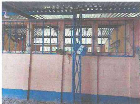
Foto 1: Se empezó a quitar los vidrios rotos en las ventanas para instalar de pvc.
