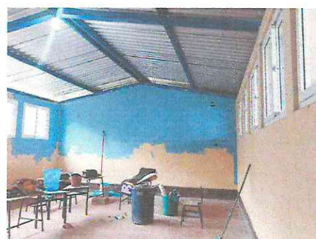
Foto 6: Se inicio el pintado de las aulas.
