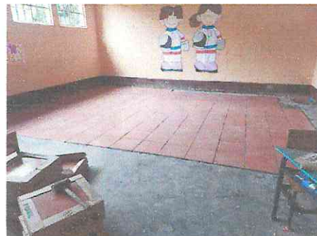
Foto 2: Se empezó a colocar el piso cerámico en la primera aula.
