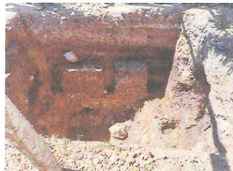
Foto 4: Se empezó a trabajar la fosa para poder colocar los baños.
